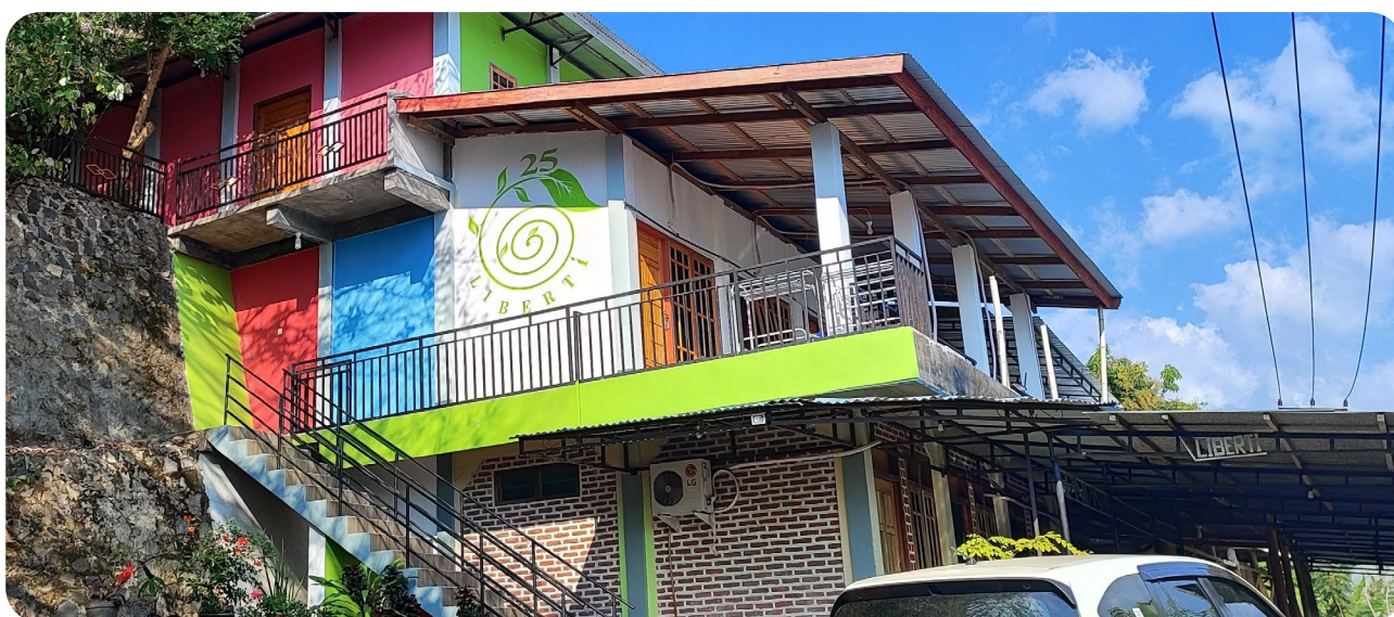
Foto 115: Salah satu sisi gedung LIBERTI tampak di lantai atas kamar-kamar penginapan (sumber foto: PLUS)
