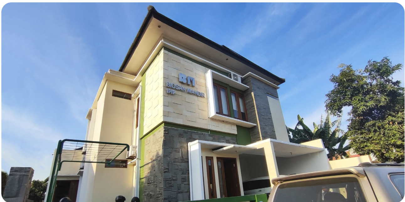
Foto 35: Gedung PT Biosan Mandiri - LPTP (sumber foto: PLUS)
